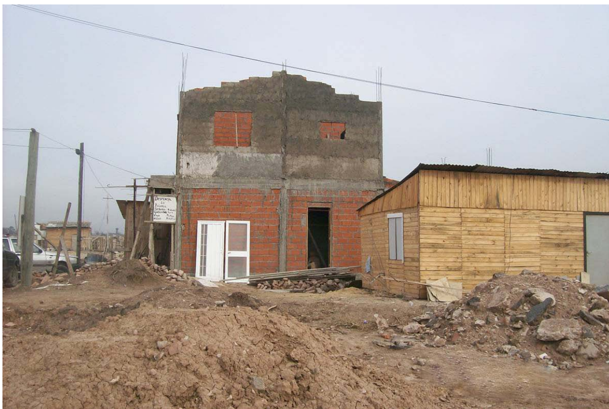
Barrio Bundge, al centro, la casa de Tatu en construcción
